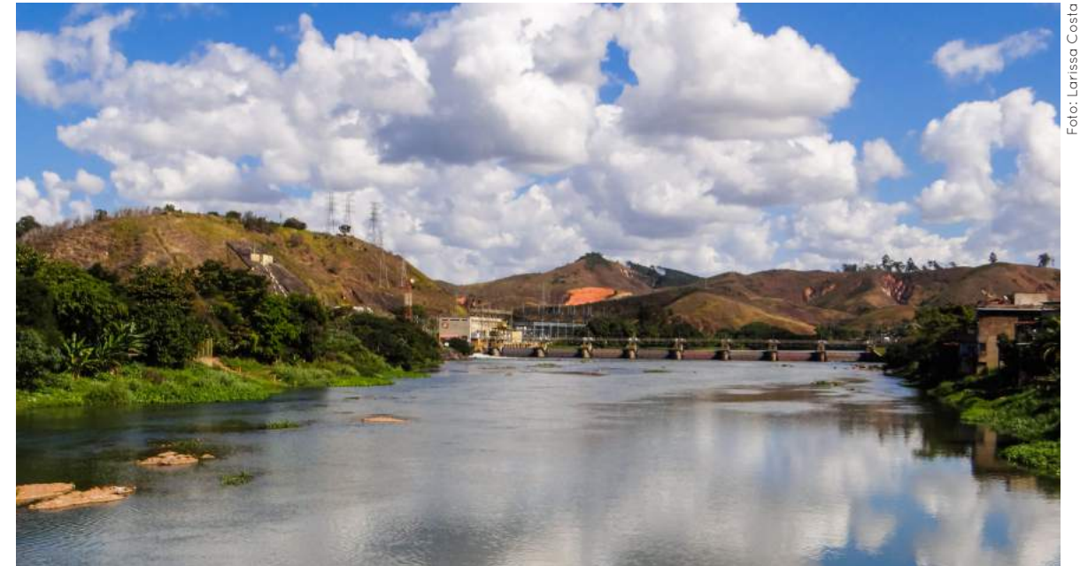
Barragem de Santa Cecília, onde ocorre a transposição de parte das águas do Rio Paraíba do Sul para o Rio Guandu por meio da estação elevatória da Light
