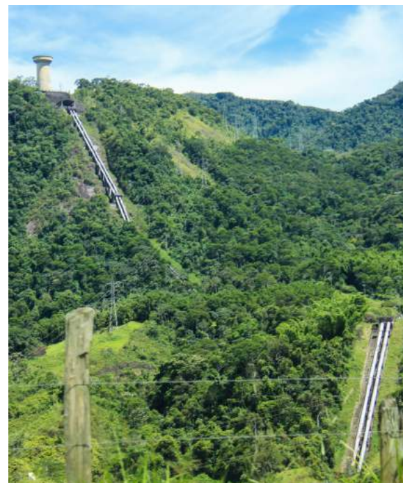
Transposição de parte das águas da Bacia do Rio Macabu (RH IX – Trajano de Moraes) para a Bacia do Rio Macaé (RH VIII - Macaé). À esquerda, local da captação, e à direita, conduto forçado para geração de energia
